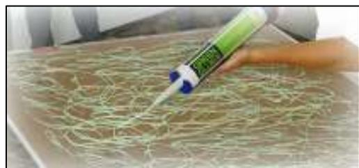
**＜床の場合＞** 右図のように既に固定された1枚目のボードにグリーングルーを塗布します。2枚目のボード1枚分の大きさの範囲で塗布してください。塗布量はサブロク板(910×1820mm)1枚あたりチューブ1本です。
